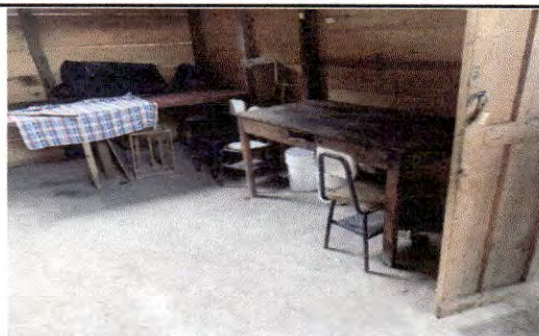
Foto 11: Piso de concreto de cocina.
